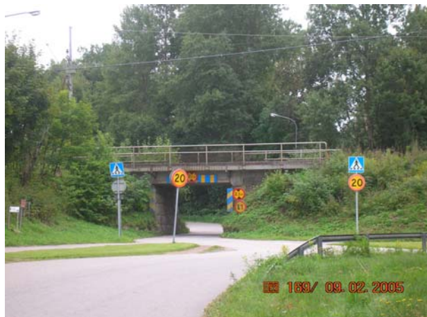
Järnvägsviadukten är smal och det är riskfyllt att passera
