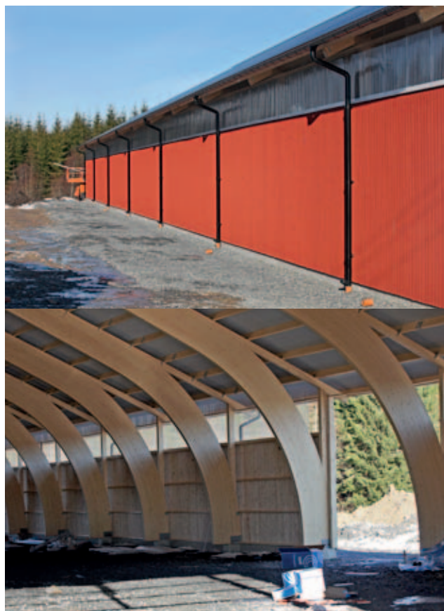
Byggnation av ridhuset i full gång.
