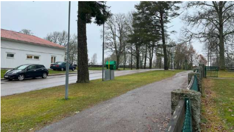
Gång- och cykelväg utmed Gamla Edsvägen
