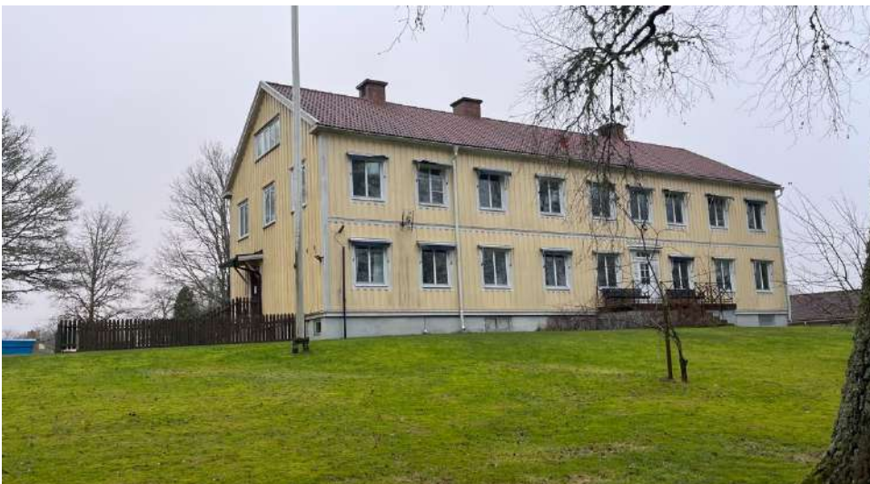
Nedan: Byggnaden från nordväst. Bildkälla: Norconsult
